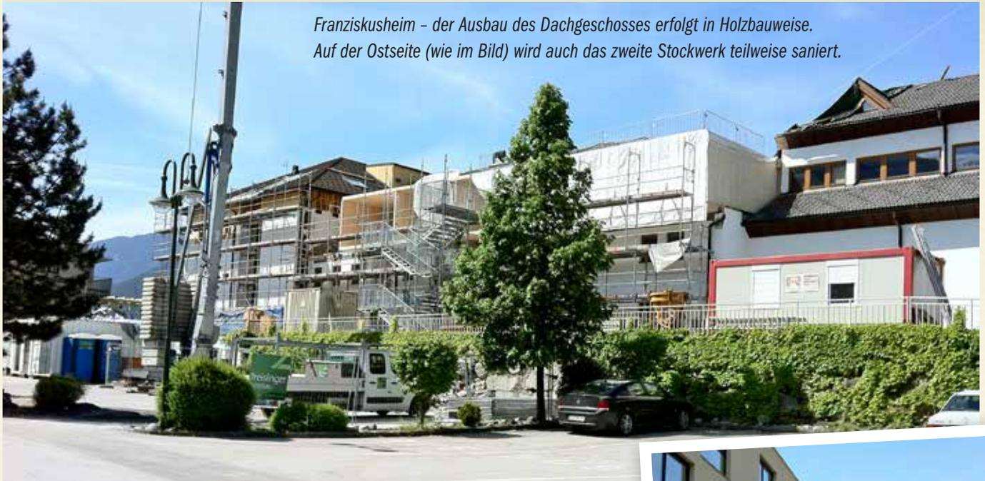
*Franziskusheim – der Ausbau des Dachgeschosses erfolgt in Holzbauweise. Auf der Ostseite (wie im Bild) wird auch das zweite Stockwerk teilweise saniert.*
